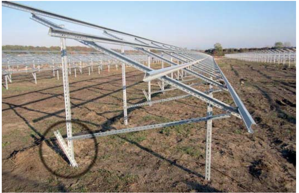
Стандартна система встановлення опор забиванням у ґрунт
